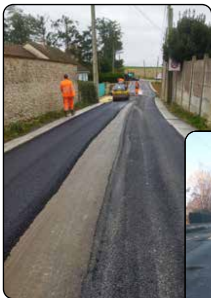
Les travaux de voirie : - Rue Saint-Avertin - Route de la Bouquinière - VC7 du Breuil à Villebouzon
