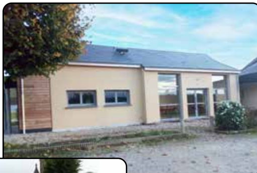
2021 : Réception des travaux
